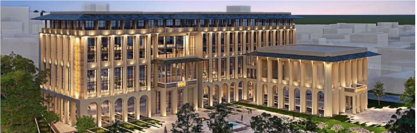
Proje İsmi : Pendik Belediyesi Yeni Hizmet Binası Şehir : İstanbul Niteliği : Özel Proje Yılı : 2025
