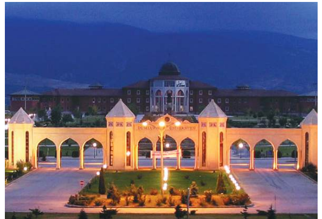
Proje İsmi : Dumlupınar Üniversitesi Besyo Bölüm Binası Şehir : Kütahya Niteliği : Kamu Proje Yılı : 2019
